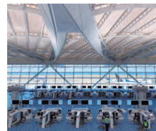
■東京国際空港(羽田)第2ターミナル 電気設備 東京都
