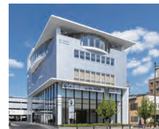
■マツシマホールディングス本社ビル 空調設備、衛生設備 京都府 Head Office Building, MATSUSHIMA HOLDINGS CO.,LTD. HVAC, Hygienic System Kyoto Pref.
