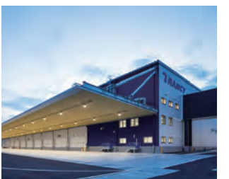
■日本トランスシティ 三重朝日物流センター 空調設備、衛生設備 三重県 Mie Asahi Logistics Center, Japan Transcity Corporation HVAC, Hygienic System Mie Pref.
