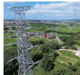
■新加古川線改良工事 電力設備 兵庫県
