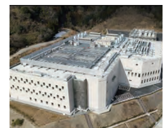
■デジタルリアルティKIX13 データセンター 電気設備 大阪府
