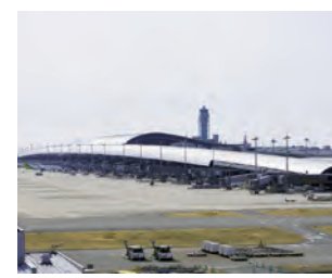
■関西国際空港 電気設備 大阪府
