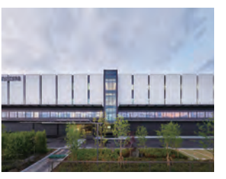
■京セラ鹿児島県分工場 電気設備 鹿児島県
