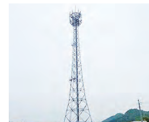
■無線基地局(2) 通信設備
