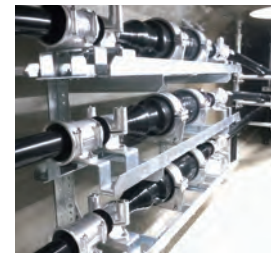
■瀬戸内Kirei太陽光発電所系統連系線 電力設備 岡山県
