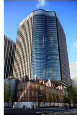
<東京都> 丸の内パークビル内 S社 情報設備工事(機器/配線)
