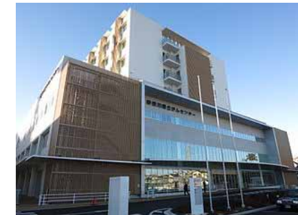
<神奈川県> 神奈川県立がんセンター 基幹ネットワーク構築工事(機器/配線)
