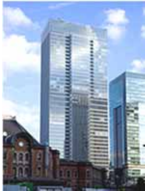
<東京都> Grantウキョウサウスタワー 内 A社 電気設備工事 情報設備工事(機器/配線)
