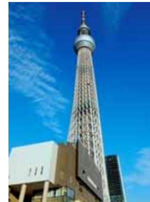
<東京都> 東京スカイツリー 情報インフラ工事(配線/機器)
