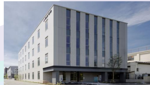
電力本部「東京工事センター」 架空・地中送電線工事における 首都圏地域の基点 (2024.9.6リニューアル)
