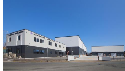
電力本部「茨城送電線工事センター」 関東圏北部地域における送電線工事の基点 (2022.3.18開所)
