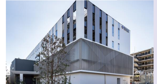
研修施設「住友電設 川崎テクニカルセンター」 各種研修施設のほか宿泊設備も備えた 当社として初の教育に特化した施設 新入社員研修をはじめ、全社における教育の拠点 (2023.3.14開所)
